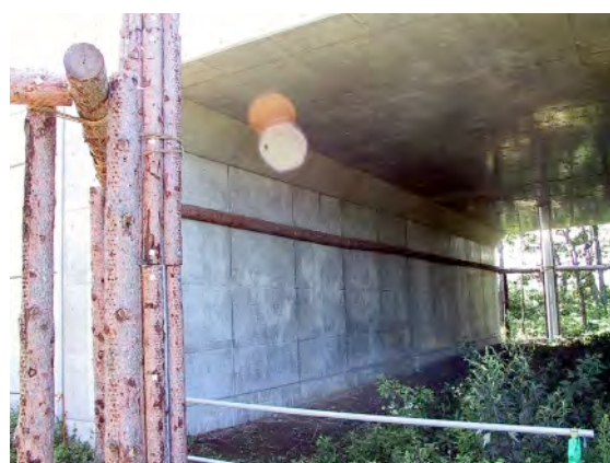
道路下のカルバート
