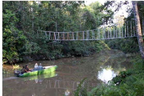
川の上に造られた吊り橋
